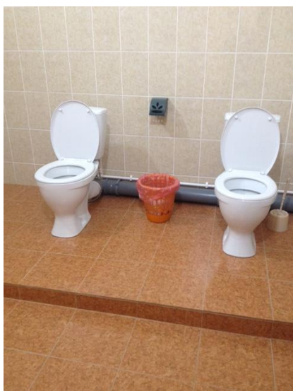
Фото № 17 . Санитарно-гигиенические помещения
