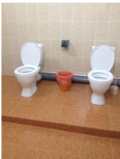
Фото № 17 . Санитарно-гигиенические помещения
